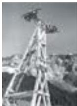
Am 8. Mai 1945 wurde mit dem Bau der ersten kuppelbaren Bahn der Welt in Flims begonnen. Da nach dem Krieg Eisenmangel herrschte, wurden die Stütze aus Holz gebaut.
