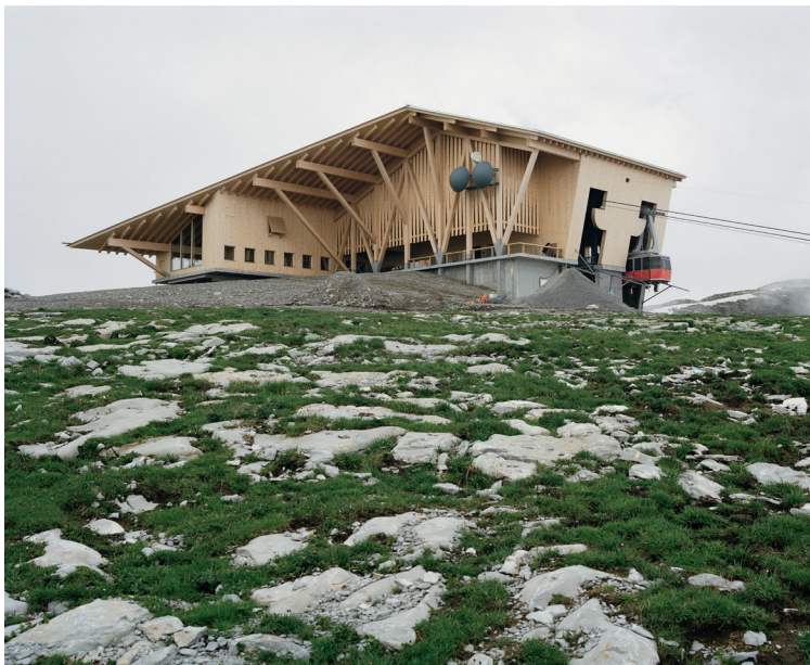
Die neue Bergstation auf dem Chäserrugg ist ein Werk der Basler Architekten Herzog & de Meuron. Foto: Katalin Deér, chaeserrugg.ch
